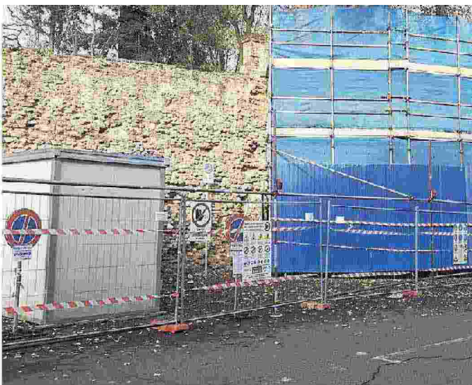
I lavori di consolidamento
