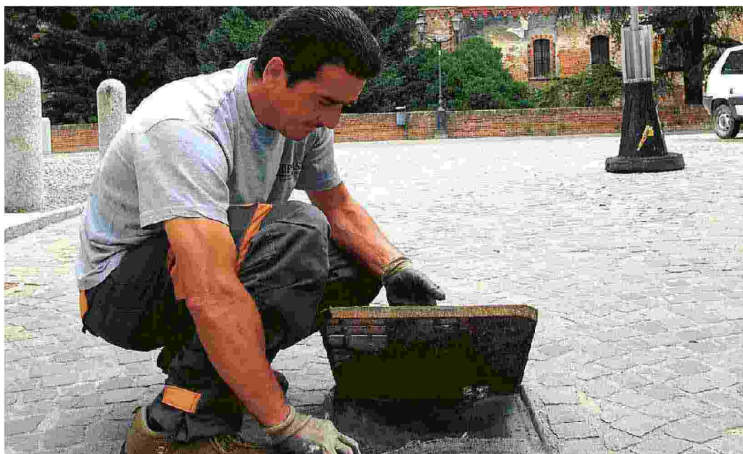
Un intervento di bonifica su un tombino nel centro di Acqui Terme
