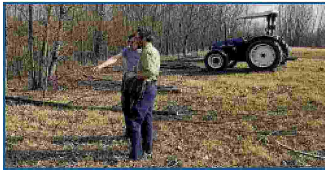
Al via i cantieri al parco Stura
